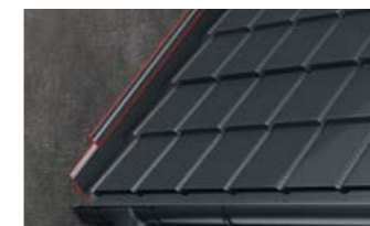
WANDANSCHLUSS MIT DILATATIONSBLECH
